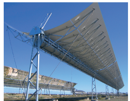
Profile für solarthermische Kraftwerke müssen hohe Lasten tragen können, aber gleichzeitig leicht zu warten sein.
